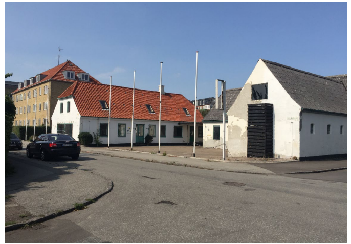
Den eksisterende bygning på Ulrik Birchs Allé 54 set fra Vatnavej. Bygningen er en gård fra 1853 og udpeges som bevaringsværdig.
