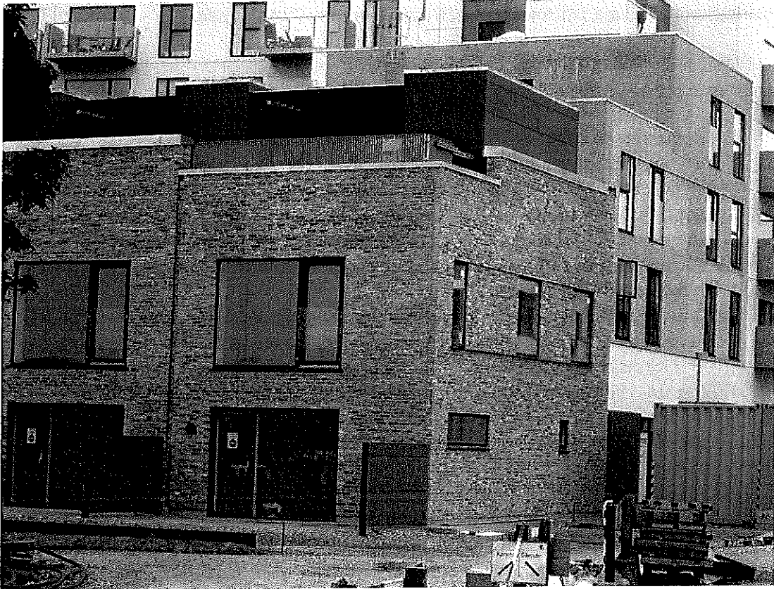
Nye rækkehuse på Krimsvej
