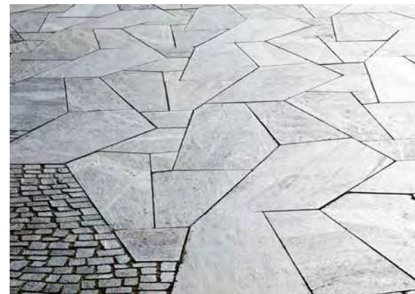
▲ Eksempel på granitbelægning
