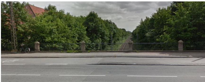
Bro for Tuborgvej over jernbanen
