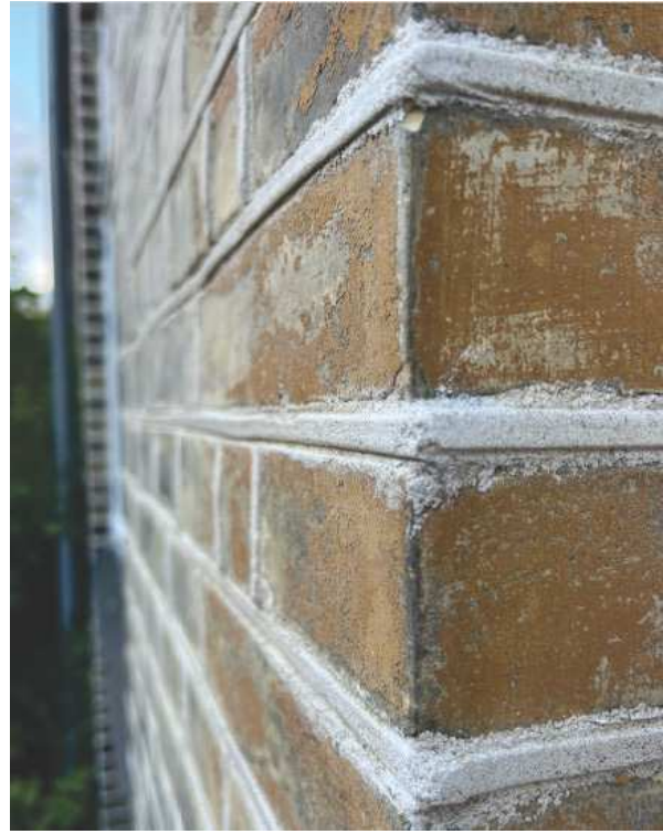
Facade i Humleby: Eksempel på facaderenovering, hvor fugerne er udskiftet med en keulet fuge i kalkmørtel i 2020/2021.
