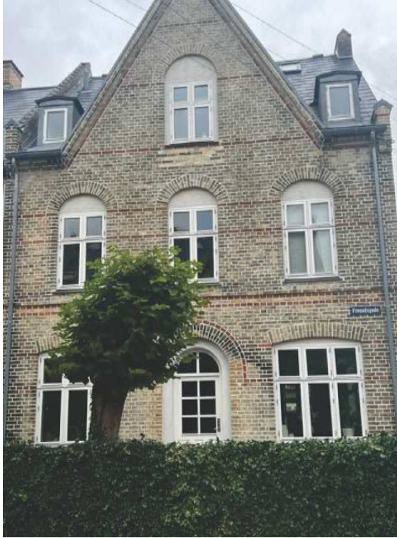
Facade i Humleby: Eksempel på facaderenovering, hvor fugerne er udskiftet med en keulet fuge i kalkmørtel i 2020/2021.
