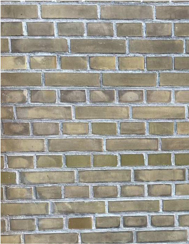
Eksempel: Murværk med ny kehlet brændt fuge. (Sankt Pauls Plads 8-10)
