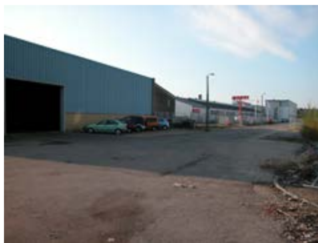
Billedet viser eksisterende bebyggelse på Østre Teglade.
