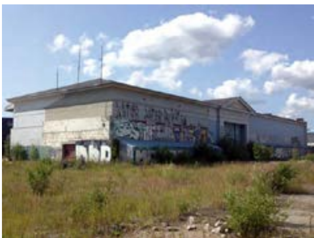
'Specialstålhallen' set fra Vasbygade
