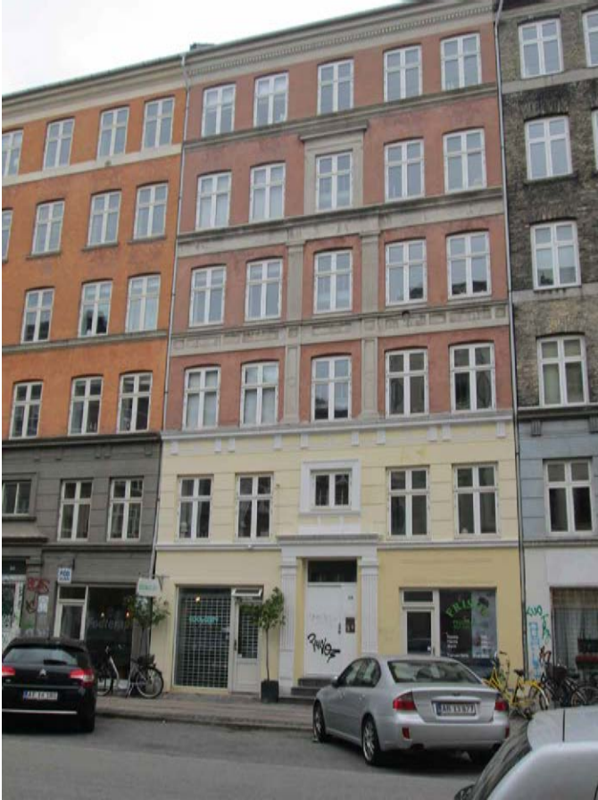
Facade mod Dybbølsgade
