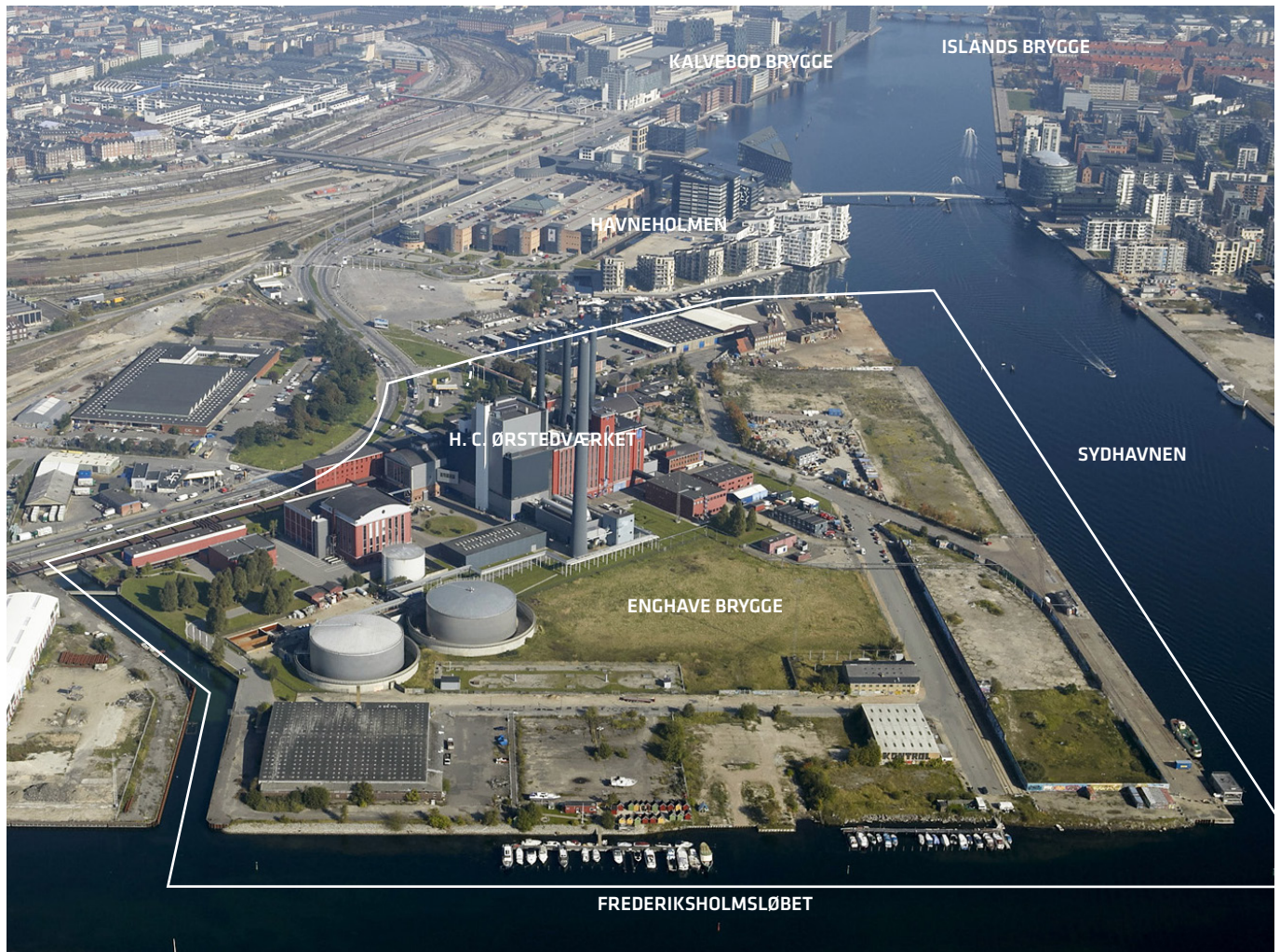
Luftfoto af Enghave Brygge set mod nord. Havneholmen, Fishetorvet, Kalvebod Brygge, banearealerne samt Islands Brygge ses i baggrunden. JW Luftfoto 2011.
