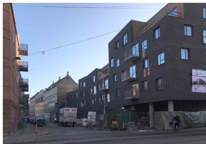
Ny bebyggelse i lokalplanområdet, på hjørnet af Geislersgade og Holmbladsgade
