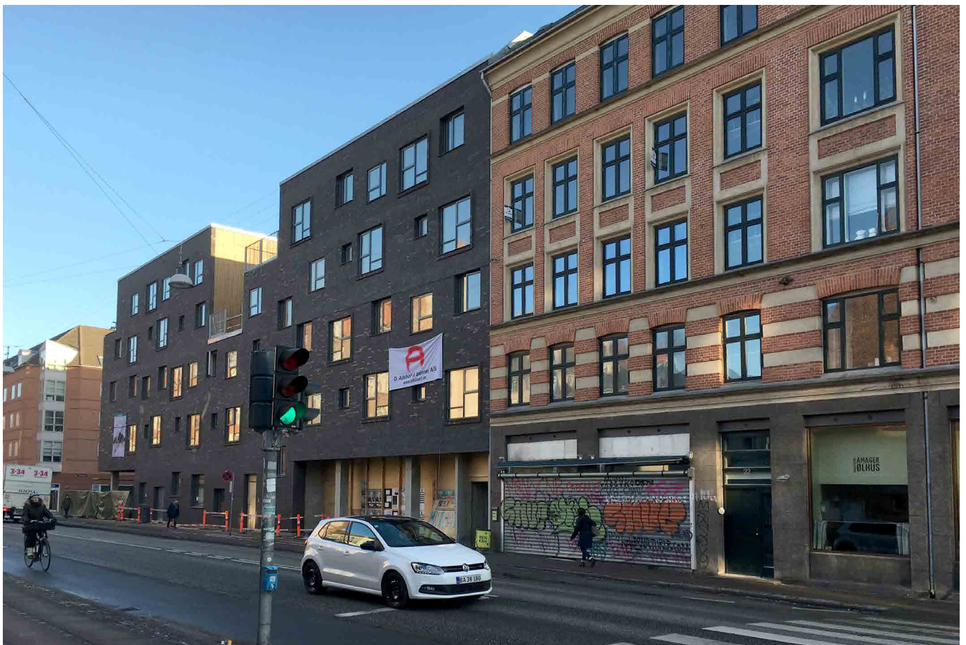
Eksisterende og ny bebyggelse i lokalplanområdet, ud mod Holmbladsgade
