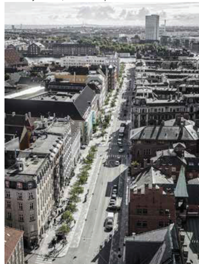
Ensidet vejtræsbeplantning på Vester Voldgade. Ekstra rækker fyldes ind, hvor der er plads
