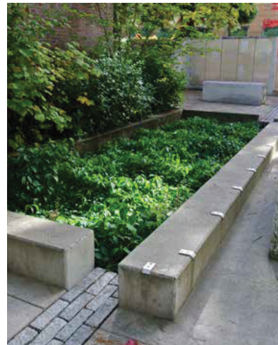
Grøn regnvandsforsinkelse på plads i Portland, USA
