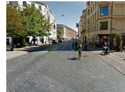
Hævet kørebane med materialeskift langs Victor Borges Plads på Nordre Frihavsgade som fartdæmpende foranstaltning
