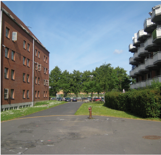
Mjølnerparkens brandveje, placeret imellem bygningerne som de fremstår i dag (set fra Superkilen). Byens Udvikling.
