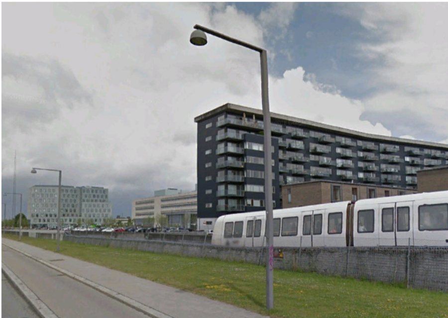
Figur 1: Viser gabionerne (stensætningen) ved rampen til Islands Brygge, der ønskes forhøjet ca. 20 cm
