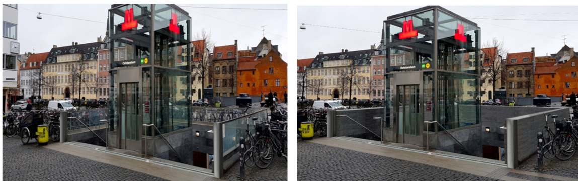
Fig. 3 Visualisering af granitværn og rille til stoplogs Christianshavns Station. Eksisterende værn tv og fremtidig th.
