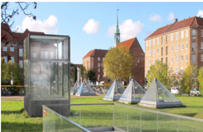
Fig. 3 Eksempel på granitsokkel på ventilationshus i Lergravsparken
