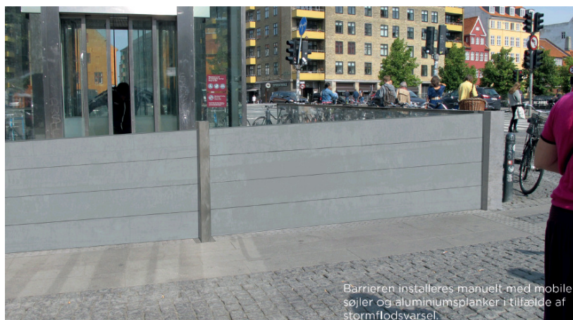
Fig. 2 Visualisering af trappenedgang på Christianshavns Station med stoplogs
