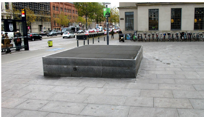
Figur 2: Visualisering af ventilationsrist med forhøjet opkant ved Kongens Nytorv.
