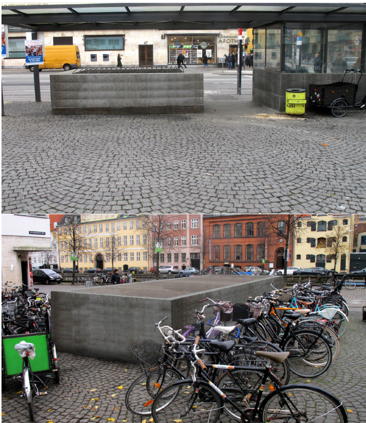
Figur 1: Visualisering af ventilationsriste med forhøjet opkant på Christianshavn Torv
