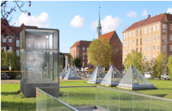
Fig. 4 Eksempel på granitsokkel på ventilationshus i Lergravsparken
