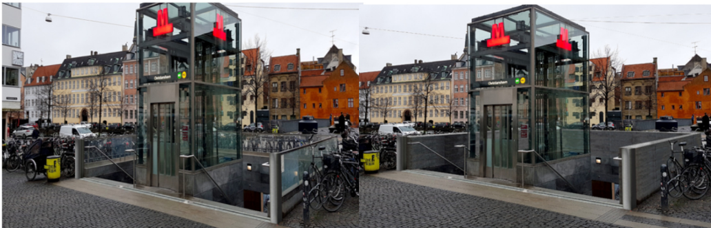
Figur 2: Eksempel på udskiftning af glasværn med beton/granitværn
