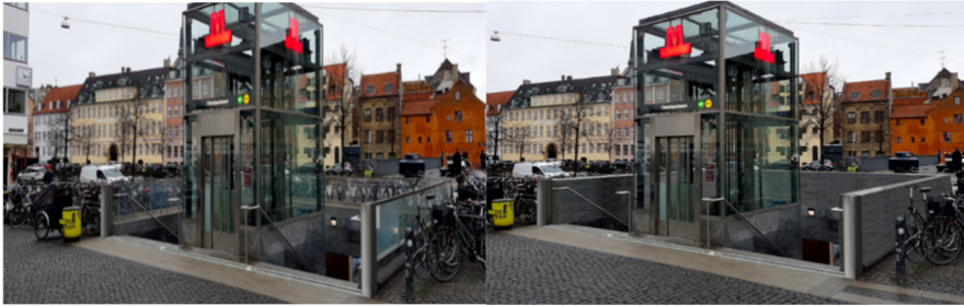
Fig. 2 Glasværn i dag tv. Glasværn fremtid th.. på begge billede ses en rille til at sætte stoplogs i
