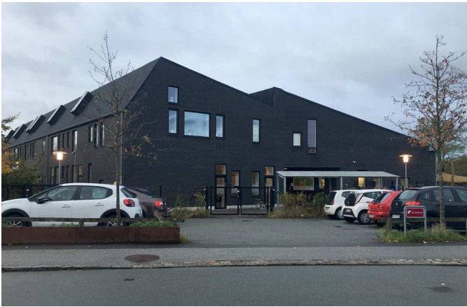
Den eksisterende daginstitution Nabohuset, der ligger i den østlige ende af området.
