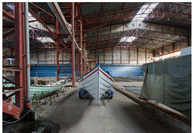
1.6 Eksisterende stålstruktur, Støbehallen
