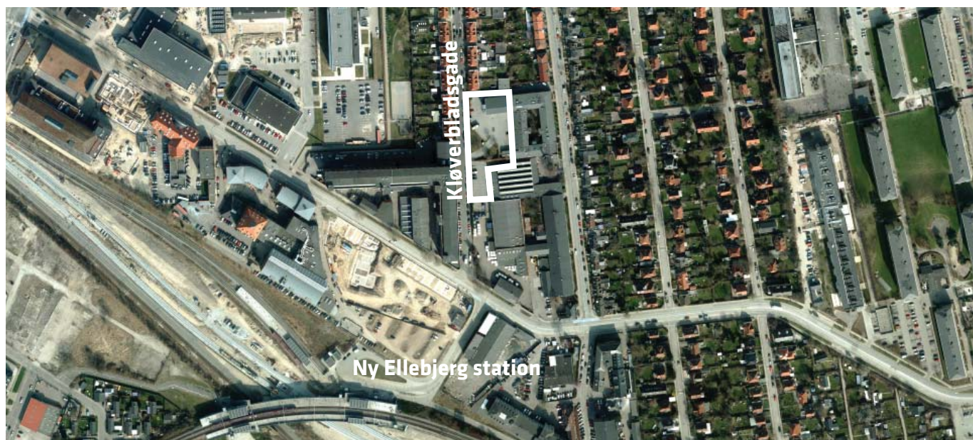
Luftfoto af området ved Ny Ellebjerg station
