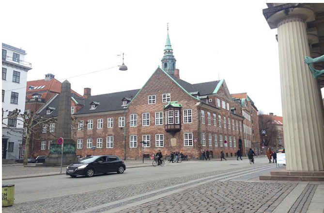
Lokalplanområdet ligger i et område med store frednings- og bevaringsinteresser og ud til Vor Frue Kirke og Københavns Universitet.
