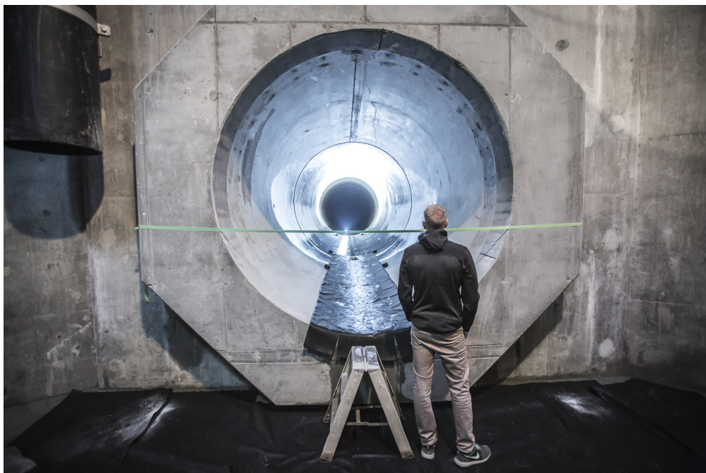
Østerbro skybrudstunnel. Foto: HOFOR
