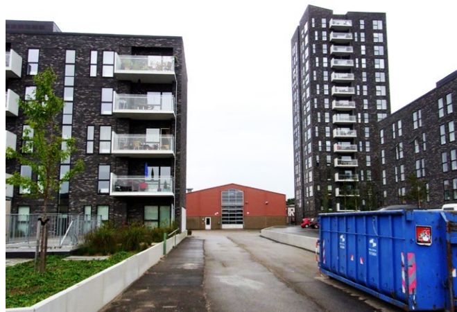
Krimsvej 17 B - den røde bygning - skal rives ned og give plads til Tværvej 4.
