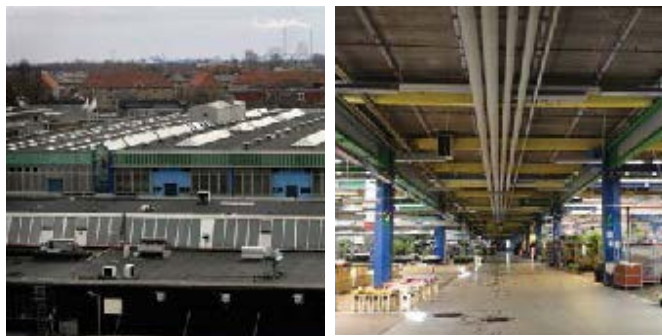
Grønttorvshallen udefra (tv.) og den indvendige konstruktion, der bevares delvist. Fotos: Polyform.
