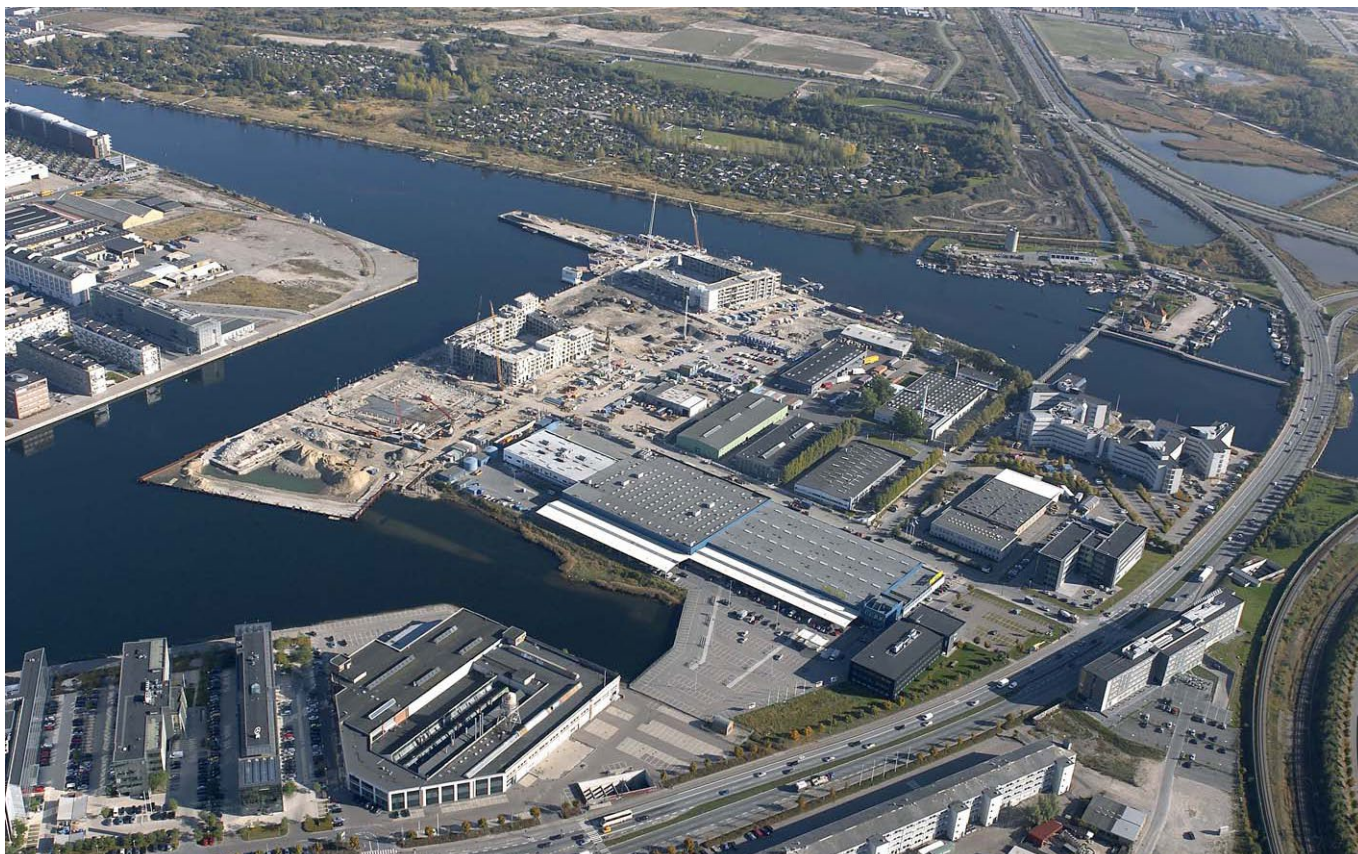
Luftfoto, der viser området "Sluseholmen Syd". Midt i billedet ligger engrossupermarkedet Metro, der forventes flyttet til et areal syd for Sjællandsbroen. Nederst i billedet den nu nedrevne Fordbygning. Til højre for Metro ses "Louis Poulsen-grunden", der er købt af Nordicom med henblik på udbygning med boliger.
