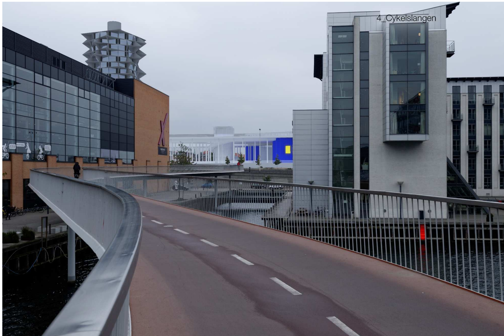
4B. Udsigt fra Cykelslangen mod Dybbølsbro – efter
