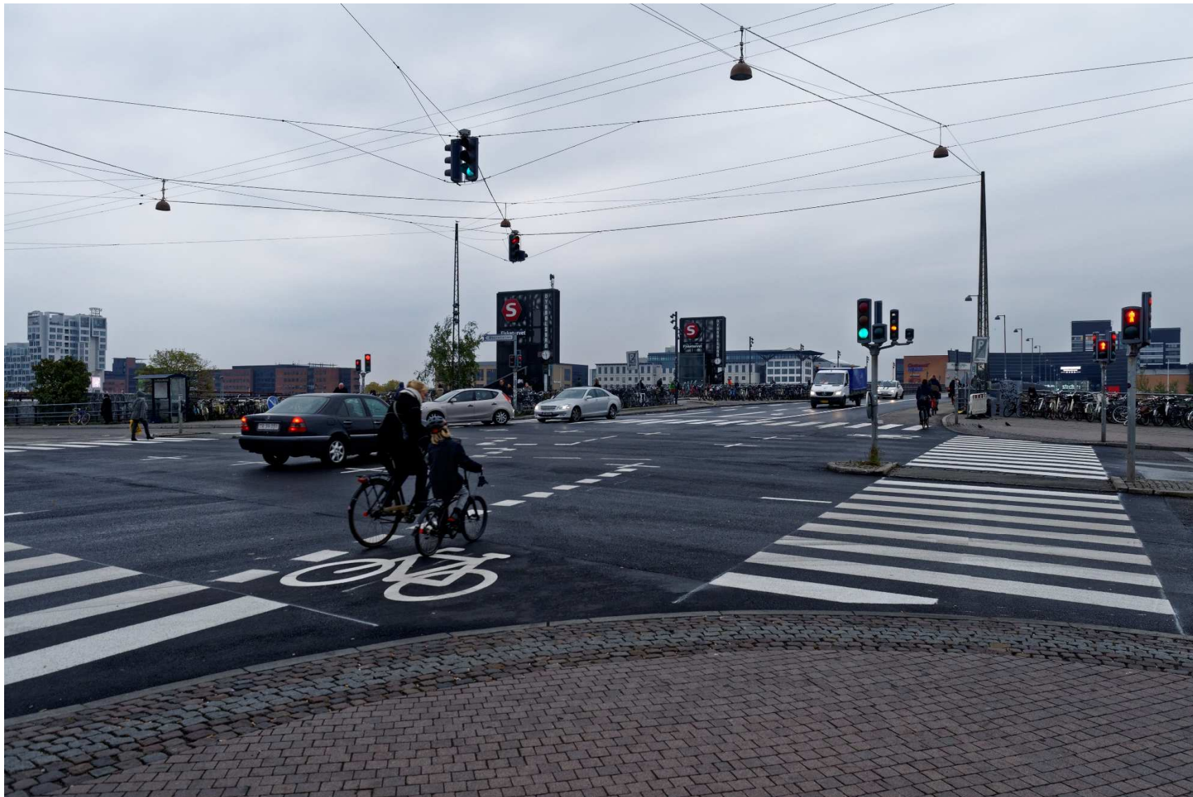
7A. Udsigt fra Ingerslevsgade ved Dybbølsbro mod projektområdet – før
