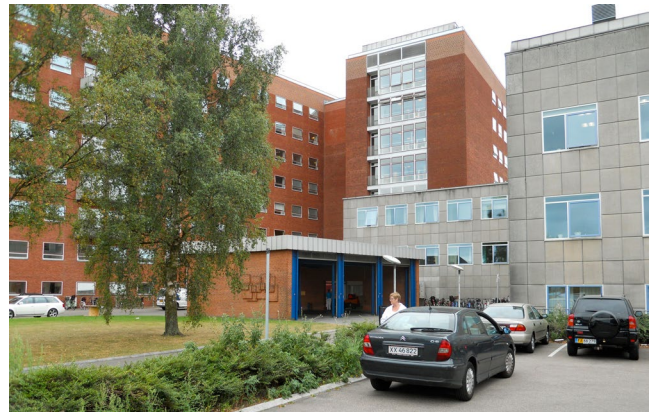
Det eksisterende Lersøkompleks set fra nord.
