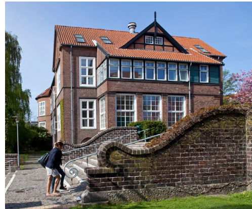
Den centrale trappe og mure med en pavillonbygning bagved. (Foto: Steen Lange).
