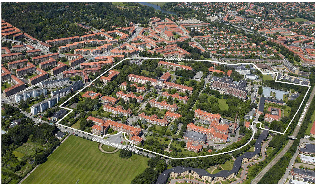
Luftfoto af lokalplanområdet og det omgrænsende kvarter set mod nordvest. (JW Luftfoto, juli 2012).
