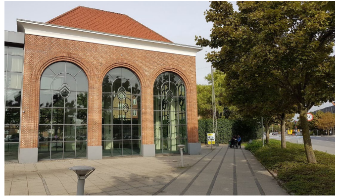
Den bevaringsværdige "Citroën-bygning" (SAVE 3) på hjørnet af Sydhavns-gade og Scandi-gade. Foto: Teknik- og Miljøforvaltningen.
