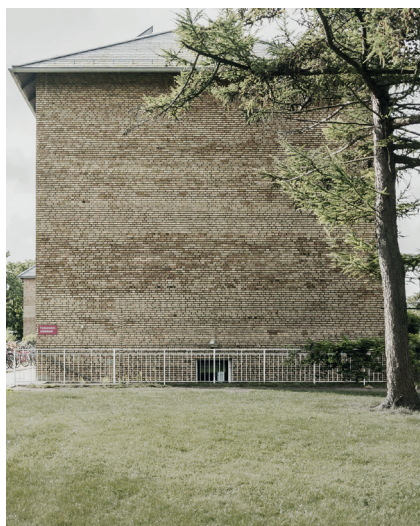
Gavl før efterisolering
