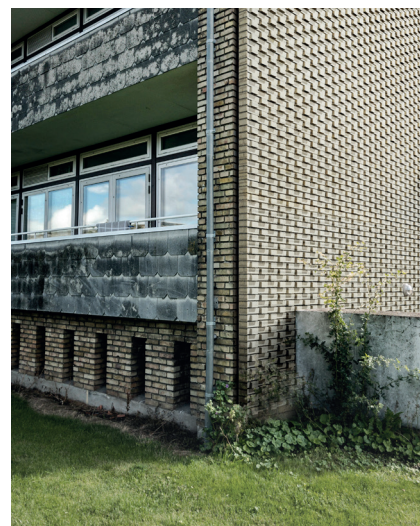
Eksempel på hjørneløsning ved efterisolering af gavl
