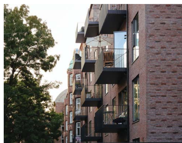
Reesser Eksempler på nye projekter med recesser i murværket Eksempler fra København og Frederiksberg.
