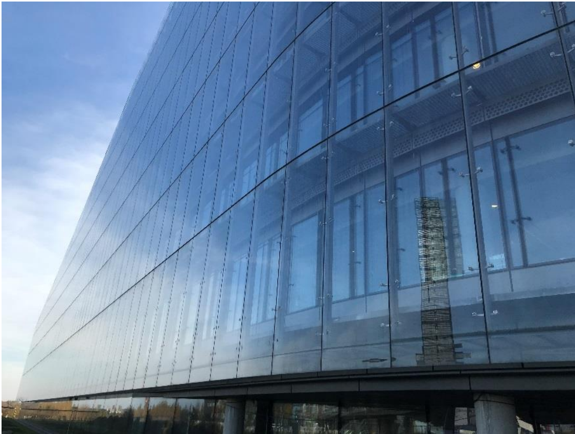
Figur B4 Billedet viser Rambølls kontor i Ørestad, Hannemanns Allé 53, 2300 København S som et eksempel på en erhvervsjendom med dobbeltfacade som støjbeskyttelse mod vej og jernbane. Foto: Rambøll.
