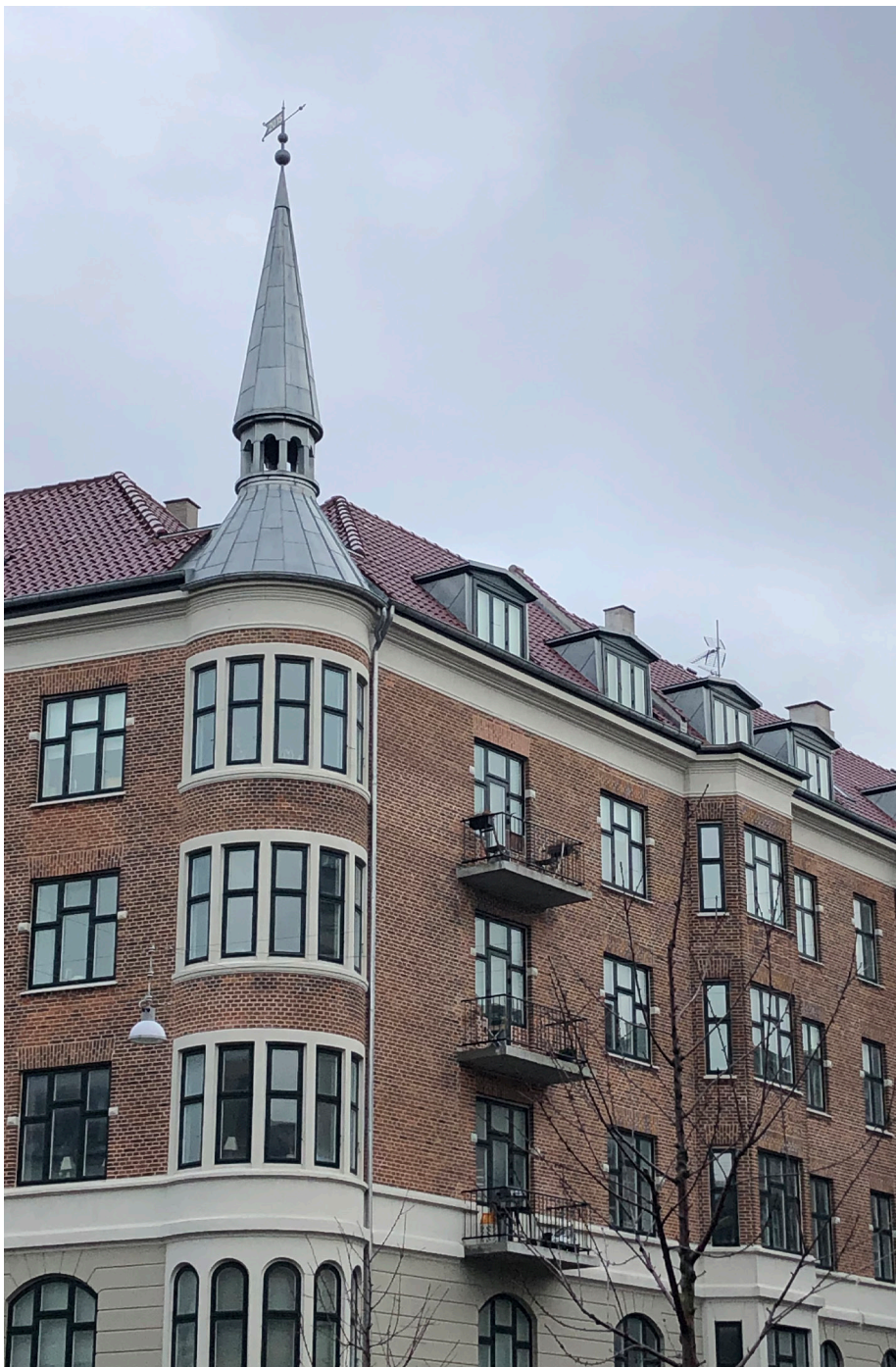
Vellykket tagrenovering på hjørnebygning, med tårn.
