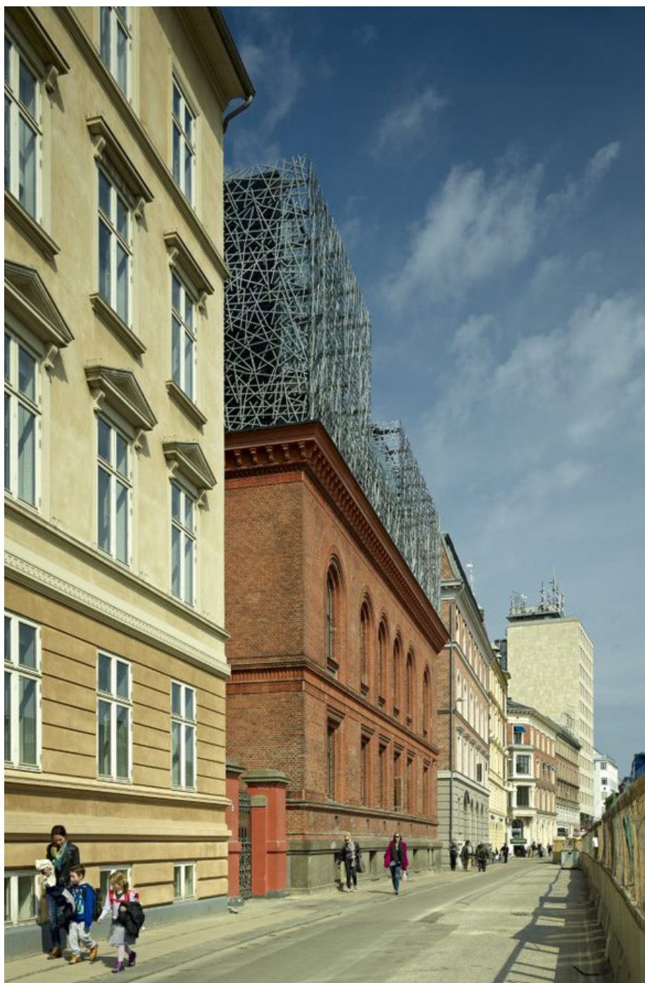
Fritliggende bygning med ny tagetage. Huset er oprindeligt opført med rejst tag, der helt er fjernet over hovedgesimsen.
