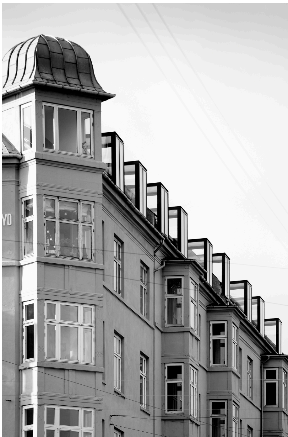
Nye kviste der med sine materialer og udformning er tilføjet som en nyfortolkning af et klassisk bygningselement.
