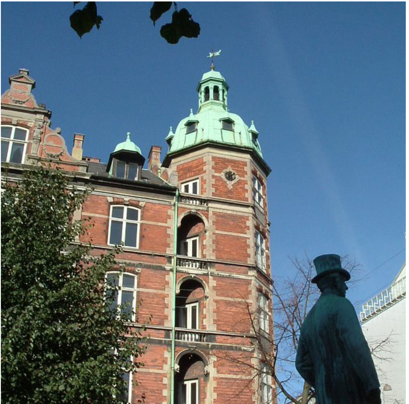
Hjørnebygning med markante arkitektoniske bygningselementer i taget.
