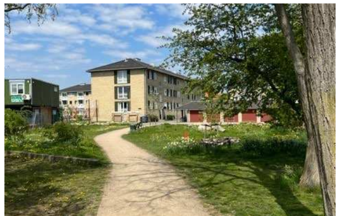
Billede set fra bydelsforbindelsen, fra syd mod nord. Strækningen løber langs den østlige del af byrummet og forbinder her Kirsebærhaven med Frugthaven. I baggrunden ses Folehavens karakteristiske boligbebyggelse.
