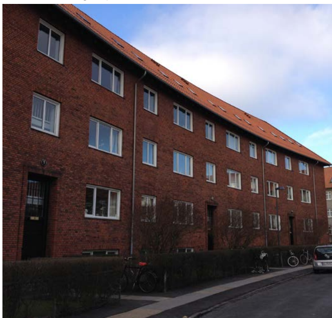
Facade mod Mågevej
