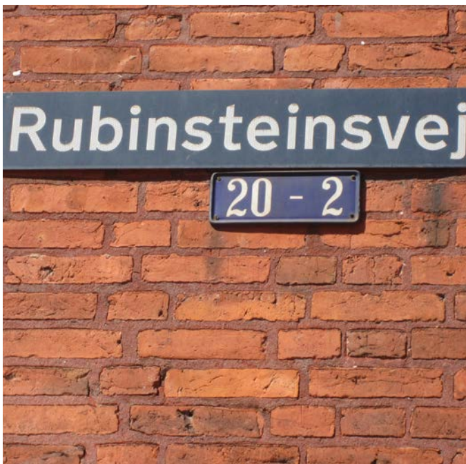
Facaden tættes ved omfugning og istandsættes i nødvendigt omfang
