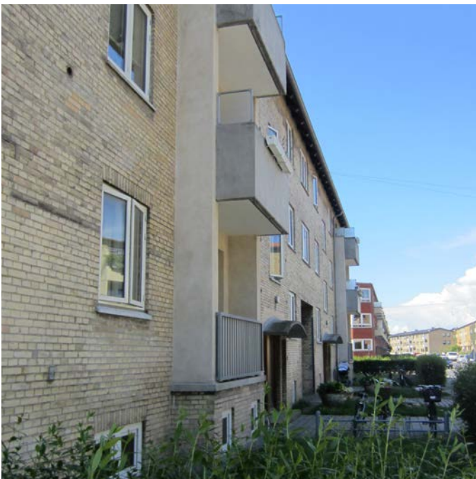
Händelsvej, efterisolering af kældergange
