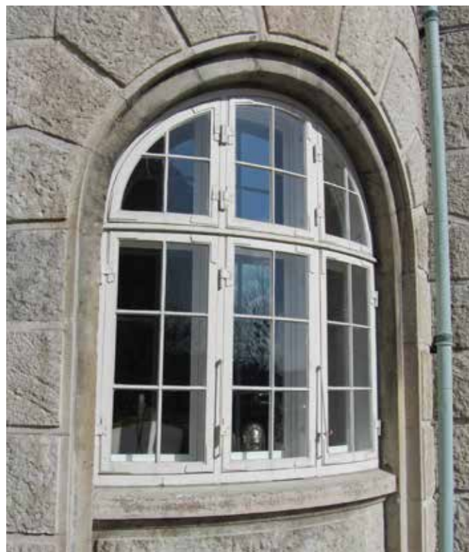
Smukke originale vinduer istandsættes og energioptimeres
