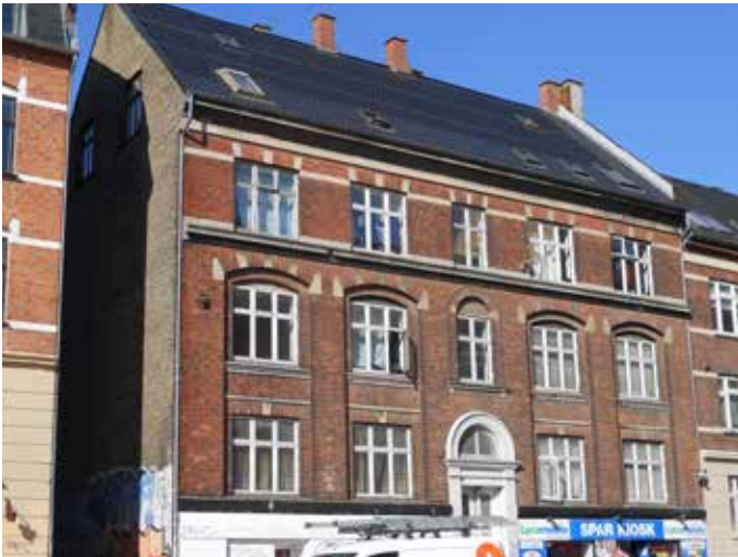
Gavl efterisoleres udvendigt og facader indvendigt
