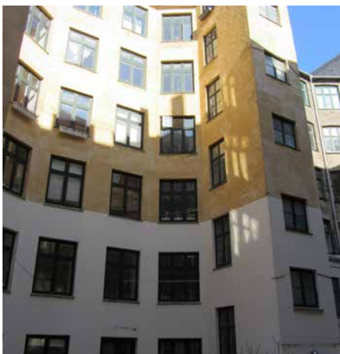
Facader istandsættes og bitrapper inddrages til wc/bad
