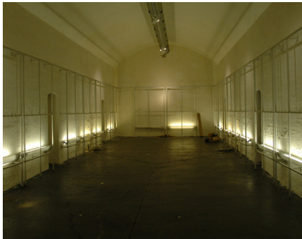
Den eksisterende kælder under pladsen.
