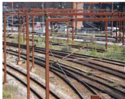
Referencefoto. Rustbrune stålmaster på baneterrænet.
