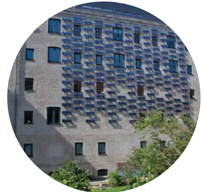
SOLCELLER TIL FÆLLES ELFORBRUG
