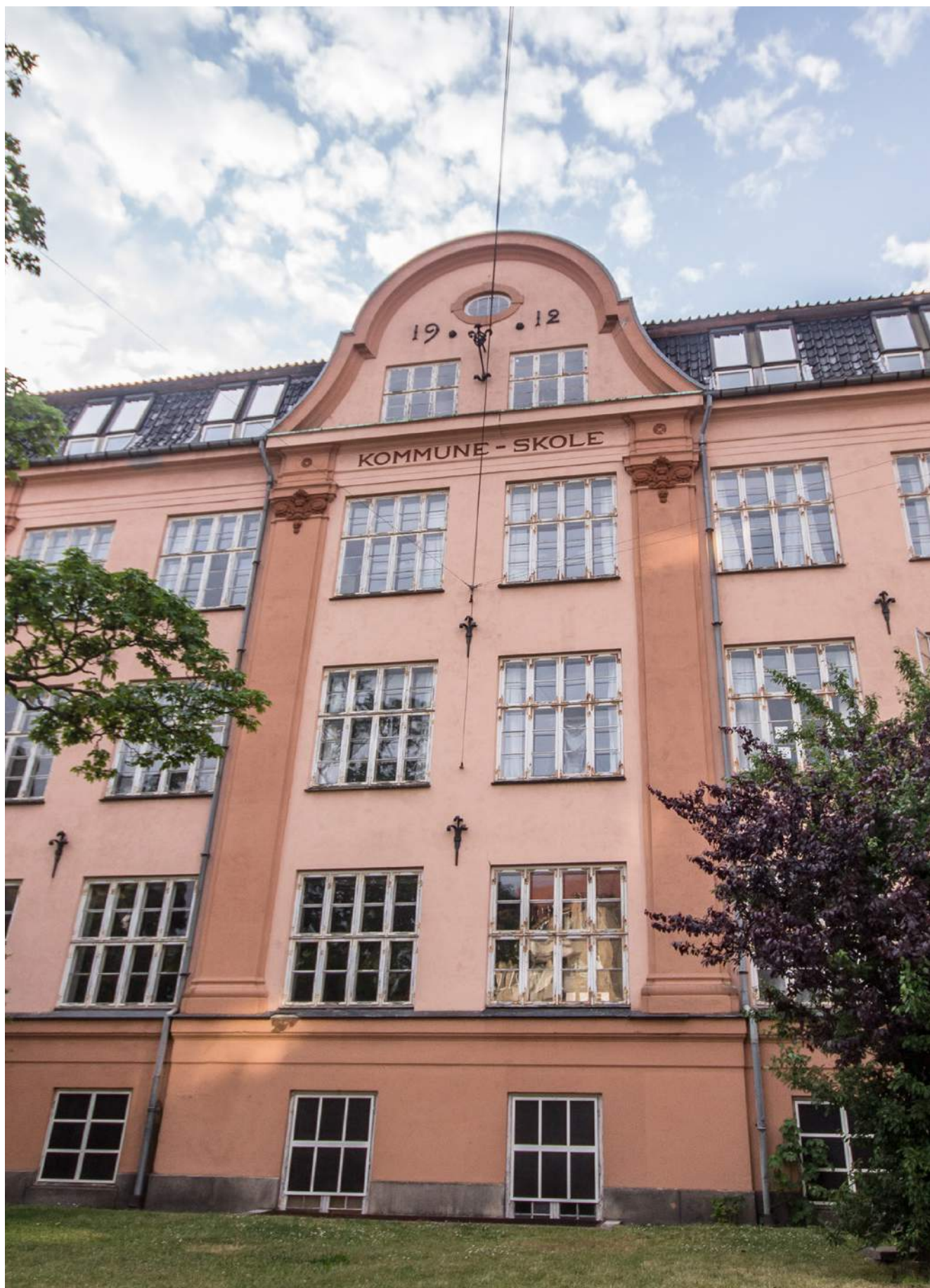
Bispebjerg Skole er en vigtig lokal- og kulturhistorisk bygning. Områdefornyelsen ønsker, at den tidligere skole bliver udviklet til et vækst- og kvarterhus, så skolebygningerne atter beriger livet i kvarteret.
