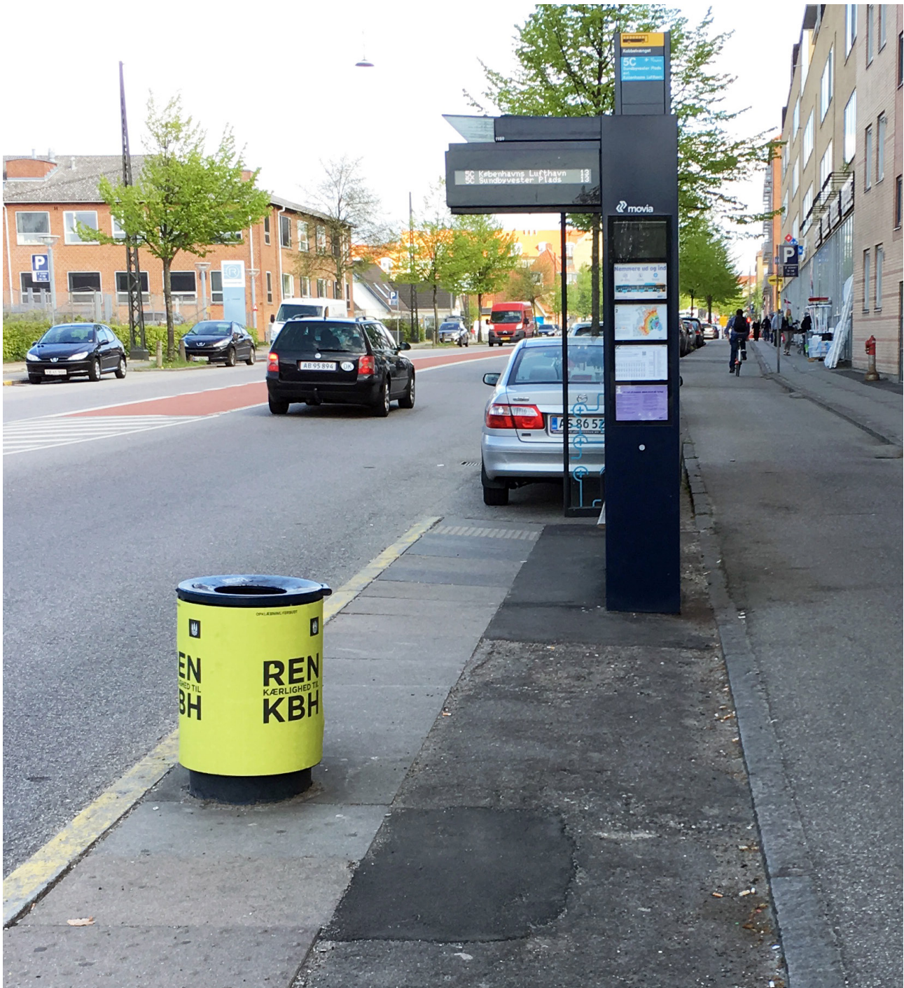
Foto af busstop på Husum Park Ruten. Busperronen er for smal, har ujævn belægning og mangler retningsfelt ved stoppestedetsstanderen.
