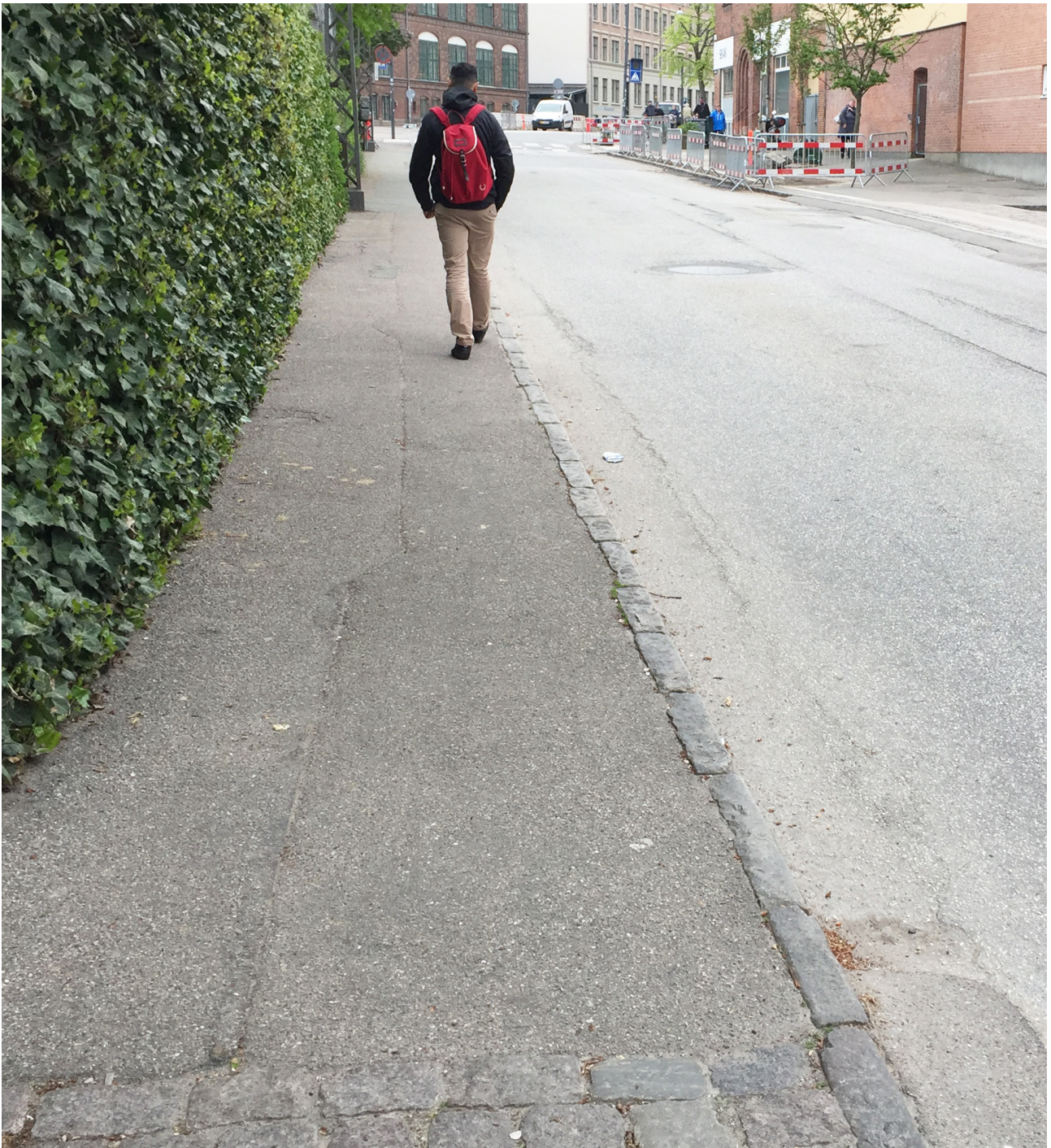
Foto af manglende ledelinje på fortovet på Valby Stationsruten.
