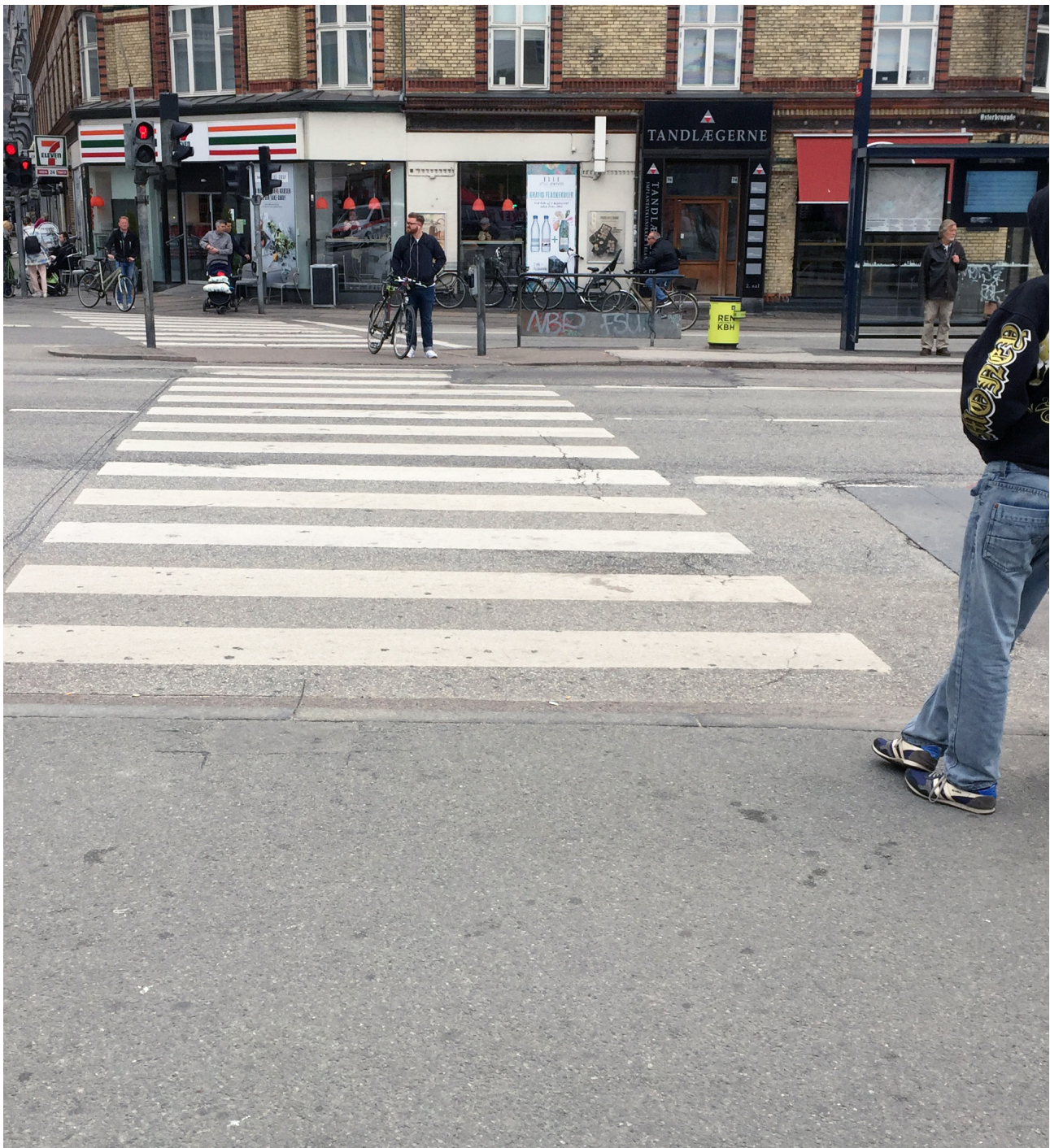
Foto af fodgængerkrydsning på Triangelruten hvor der bl.a. mangler retnings- og opmærksomhedsfelt, nulkant samt opspring for blinde.
