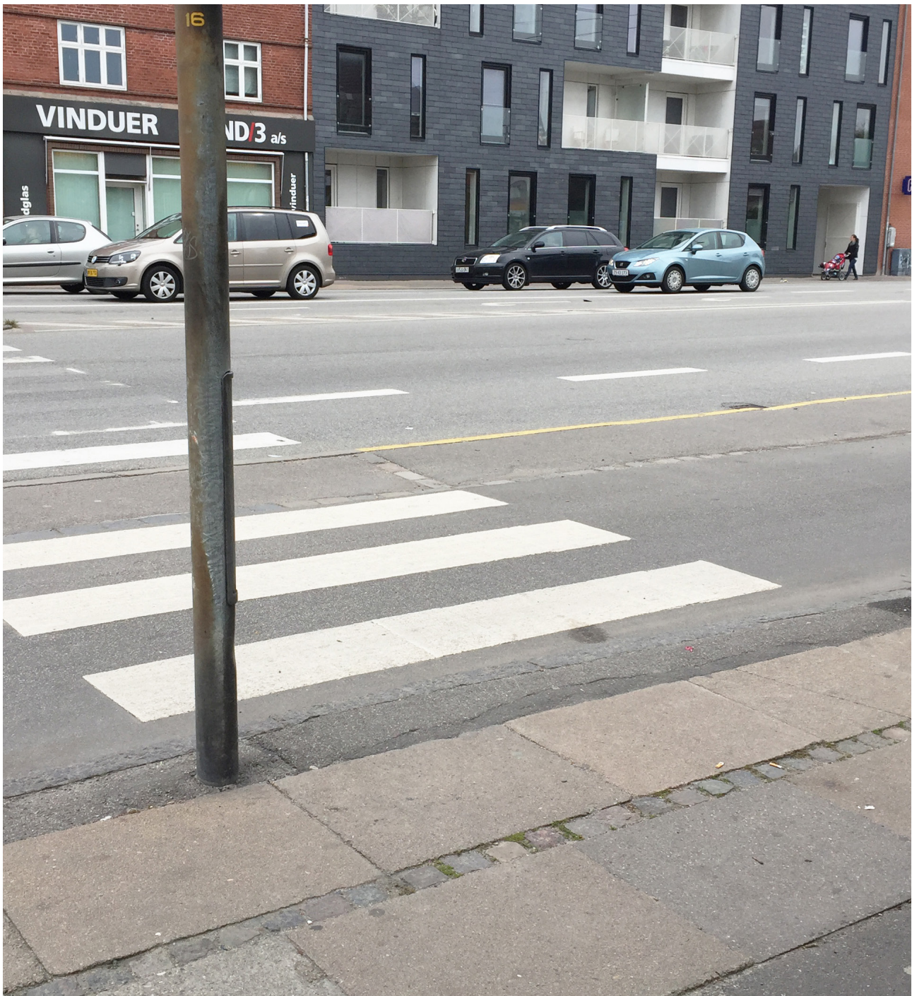
Foto af fodgængerkrydsning på Ålekisteruten hvor der mangler retnings- og opmærksomhedsfelt, nulkant og opspring for blinde.
