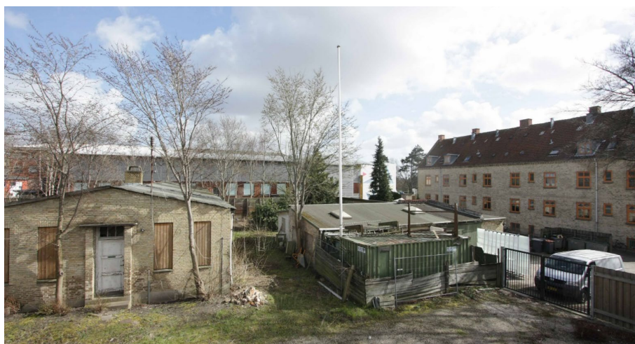
Frederikssundsvej 278 - gårdside med skure set fra vest med Frederikssundsvej 276 i baggrunden.
