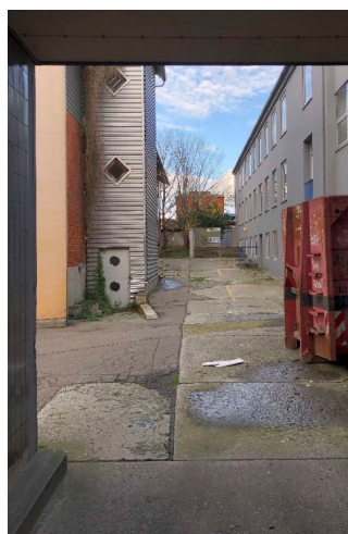
Smøge mellem Frederikssundsvej 276 og 274 set fra syd. Foto: Skovhus Arkitekter.
