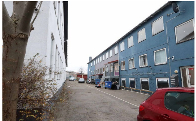
Th. Gadelandet 18 set fra nord - bygningen bevares. Foto: Skovhus Arkitekter.
