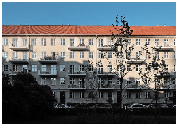
Humlebækgade. Altanerne er sat op efter et fast system der kan aflæses selvom alle ikke har fået altan.
