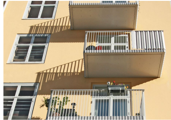
Mikkel Vibes Gade. Hvide altaner med enkel raffineret konstruktion der beriger facaden og matcher vinduer.
