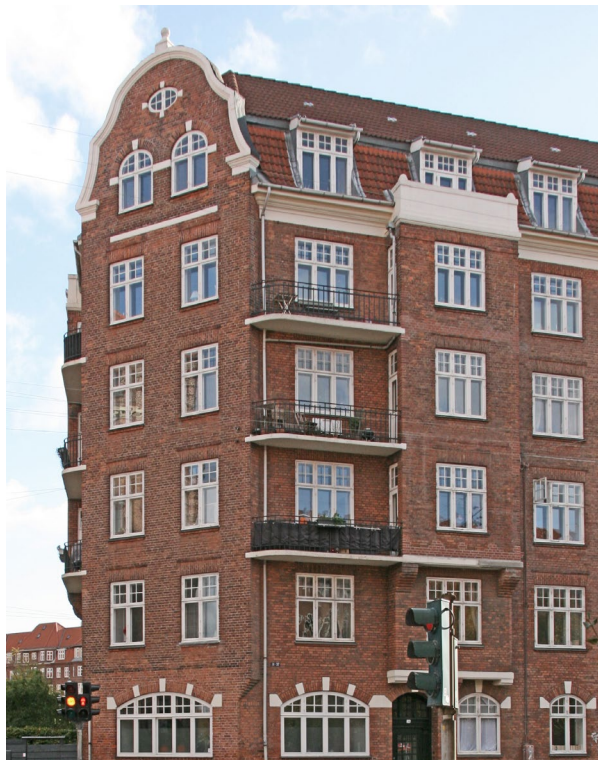
Amager Fælledvej. Originale altaner bygget sammen med karnap.
