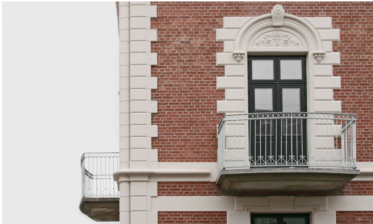
Valdemarsgade. Den smukke stoflighed og detaljering i betonbunden skaber sammen med de elegante spinkle værn og den let rundede front en god helhed sammen med de eksisterende dekorationer på facaden.
