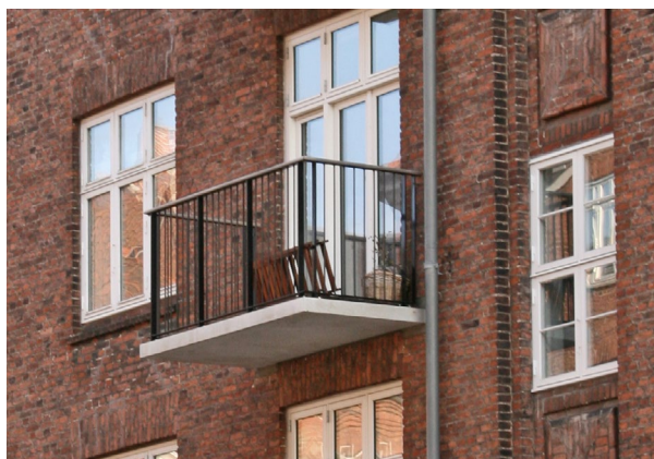
Busstrupgade. Den enkle tynde altan bund matcher facadens detaljegrad og stoflighed.
