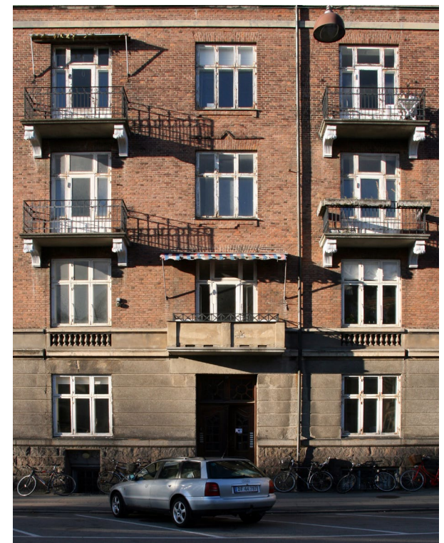
Kastelvej. Oprindelige altaner i forskellige udformninger, der forholder sig til deres placering på facaden.
