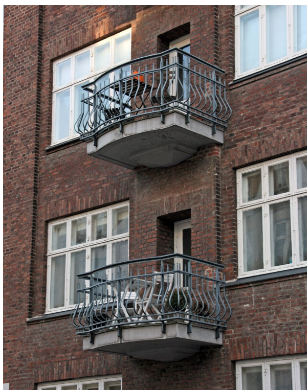
Sankt Thomas Allé. Den robuste bund har en detaljering og stoflighed der passer til den murede facade.
