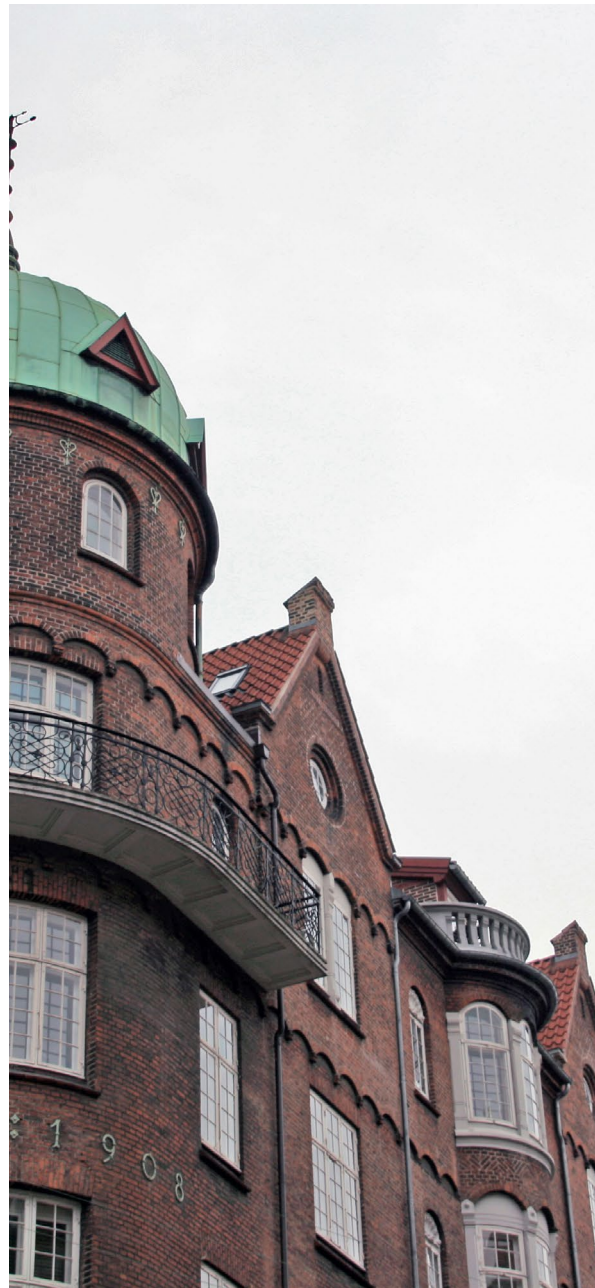
Christian IX's Gade. Den lette og smukt detaljerede altan følger og understreger facadens buede form.
