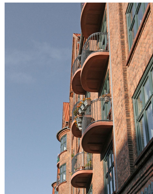
Amager Boulevard. De teglfarvede støbte bunde har en detaljering og stoflighed der harmonerer med facaden.
