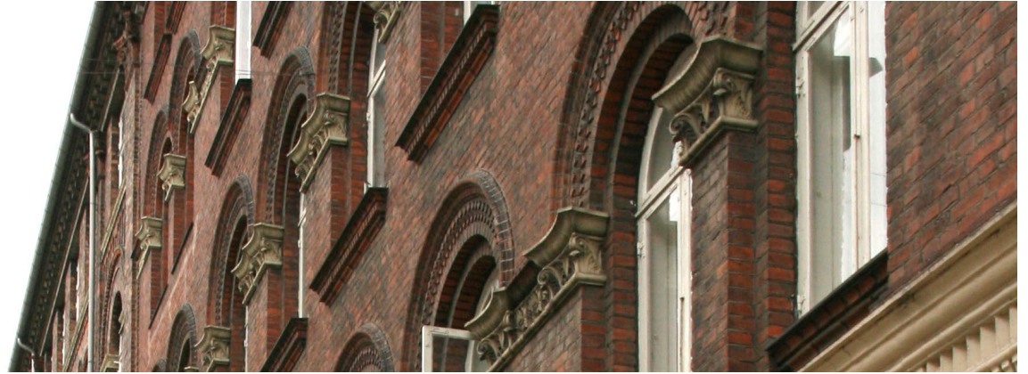
Holbergsgade. Detaljerig muret facade med rundbuer
