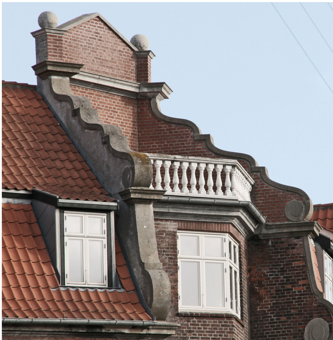
Snorregade. Oprindelig tagterrasse i mansardtag.
