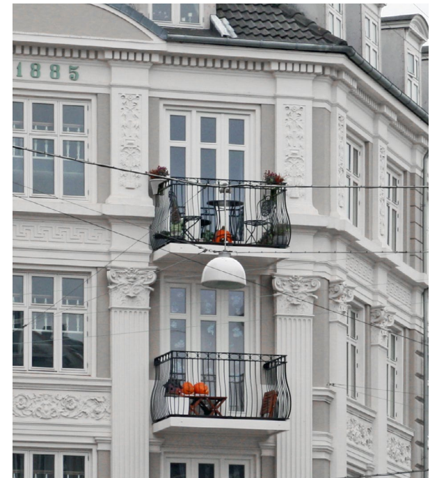
Istedgade. Altanerne fjerner dekorationen mellem søjlerne, men respekterer de lodrette søjler. Sammen med den enkle hvide bund og de fint tilpassede spinkle værn skabes en god helhedsvirkning.
