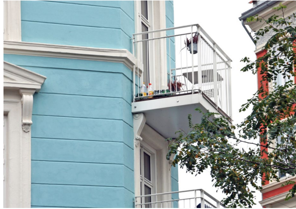
Dybbølsgade. Dekorationen er blevet delvist fjernet med god virkning sammen med den moderne altan.
