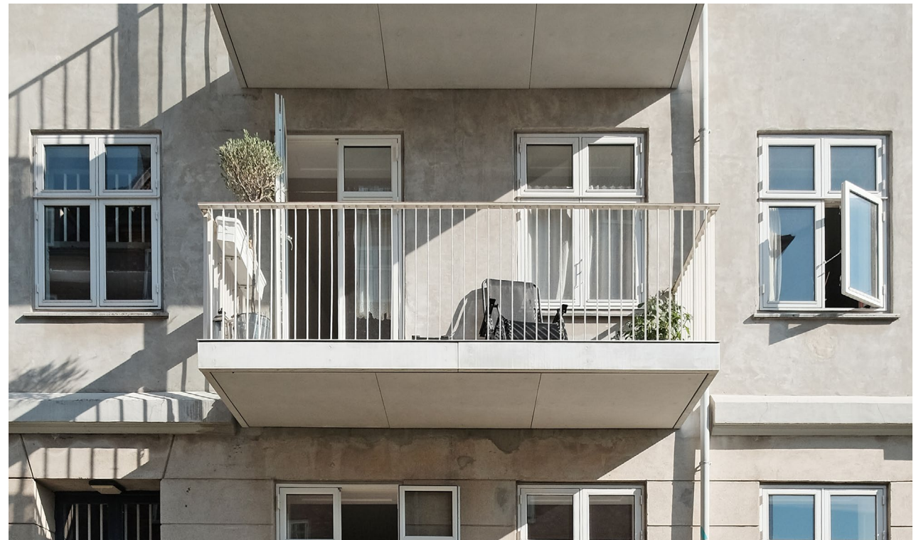
Gilbjerggade. Enkle lyse altaner der passer til facadens lyse nuancer og stoflighed. De spinkle værn og den enkle altanbund får altanerne til at virke svævende og lette.
