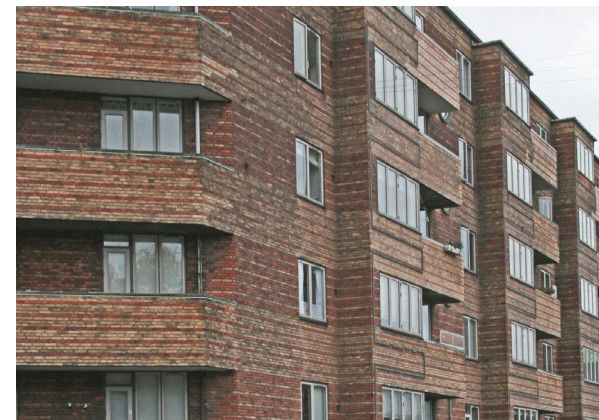
Sankt Kjeldes Plads. Oprindelige murede altaner der følger vinduesbåndene som et centralt motiv på facaden.
