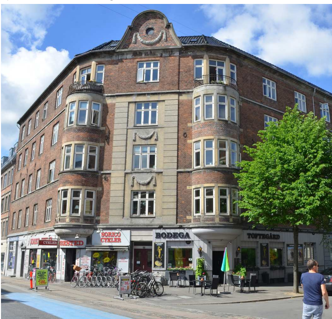
Ejendommen set fra gaden.
