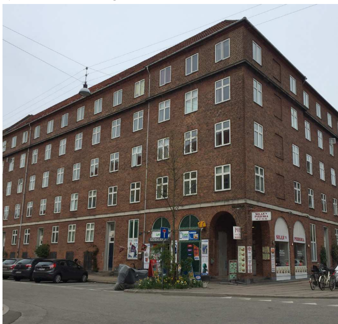
Ejendommen set fra gaden.
