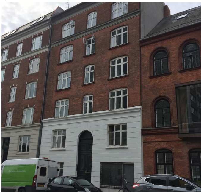
Ejendommen set fra gaden.
