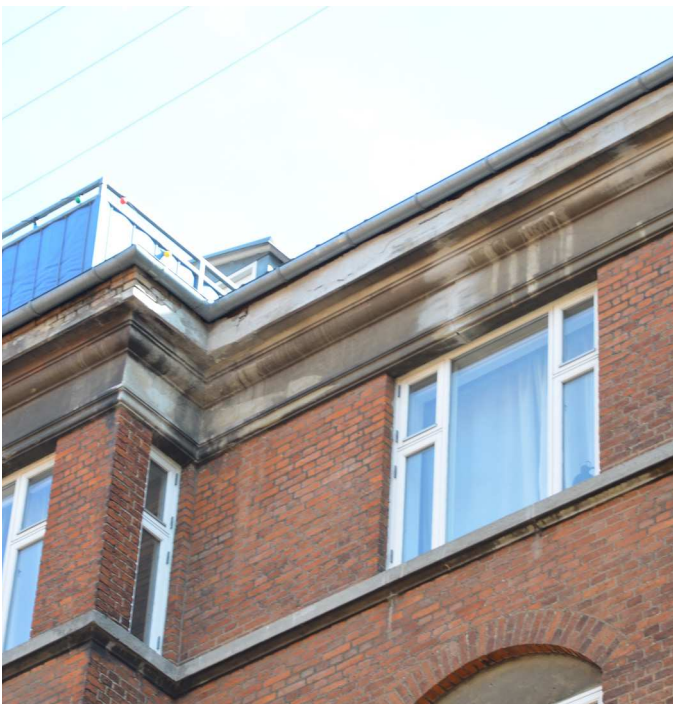
Vinduer udskiftes og facade renoveres.
