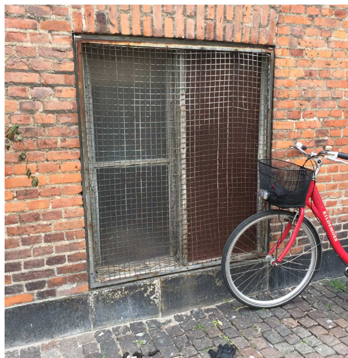
Kældervinduer er originale etlagsvinduer, der er nedslidte.
