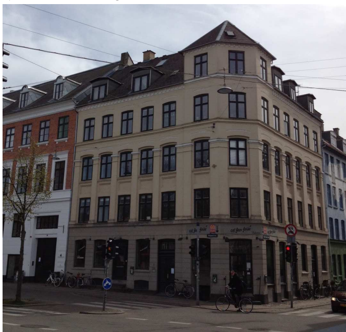
Ejendommen set fra gaden.
