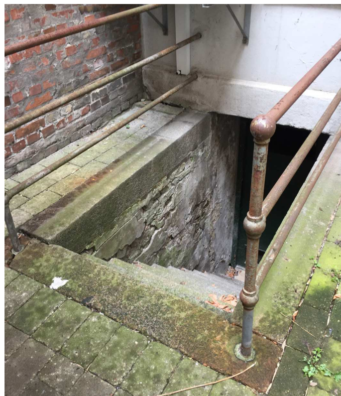
Ejendommen skybrus sikres med omfangsdræn og opkanter.
