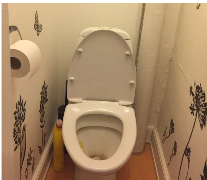
Utidssvarende "Bak-ind" toilet uden bad.
