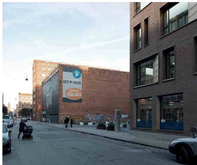
Foto af de eksisterende forhold set fra Adelgade mod nord. Foto: Kim Utzon Arkitekter.
