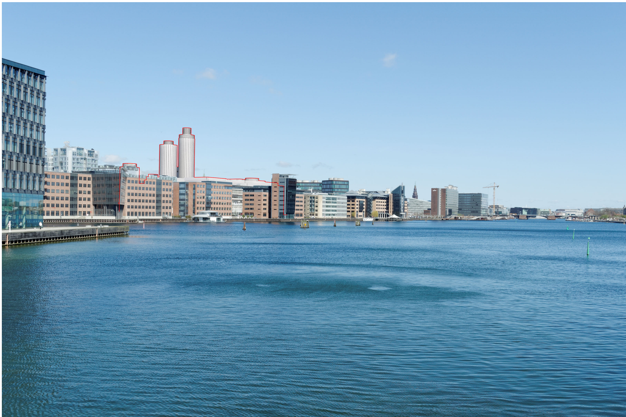
21. Bryggebroen med markering De nye tårne er synlige fra Bryggebroen bag bebyggelsen på Kalvebod Brygge.
