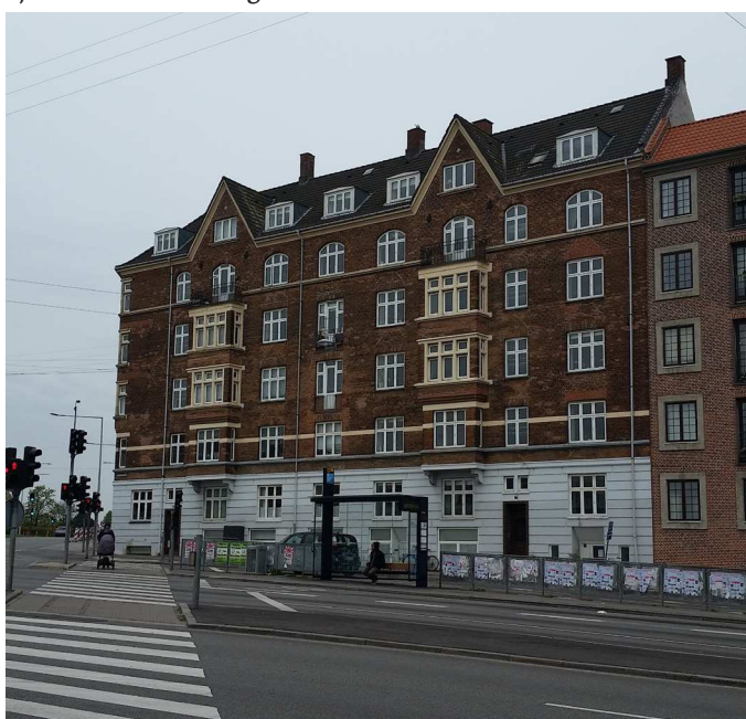
Ejendommen set fra gaden.
