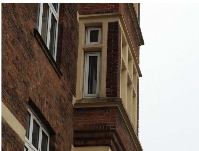
Vinduer istandsættes og lydisoleres.
