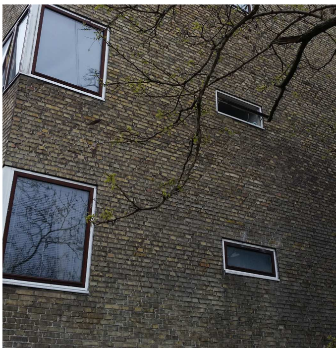
Vinduer udskiftes og lydisoleres.
