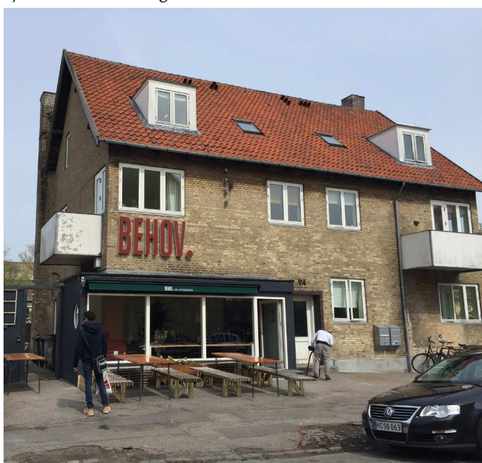
Ejendommen set fra gaden.
