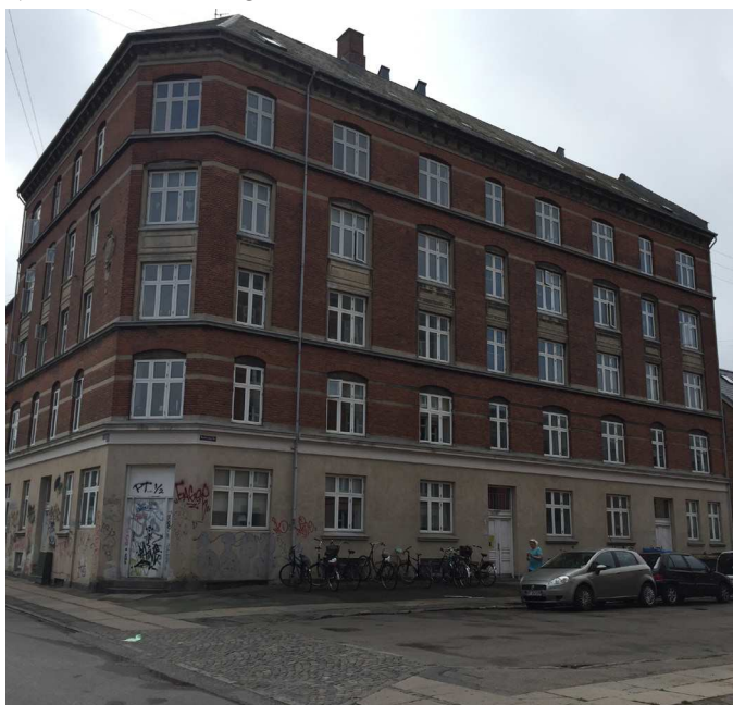
Ejendommen set fra gaden.
