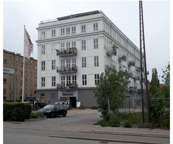
Den bevaringsværdige bygning på naboejendommen vest for lokalplanområdet, Holmbladsgade 111.
