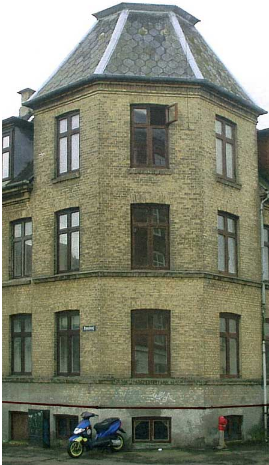
Hjørnet af Provstevej 9 og Thoravej 21A i Københavns nordvest-kvarter umiddelbart før nedtagningen i 2009.
