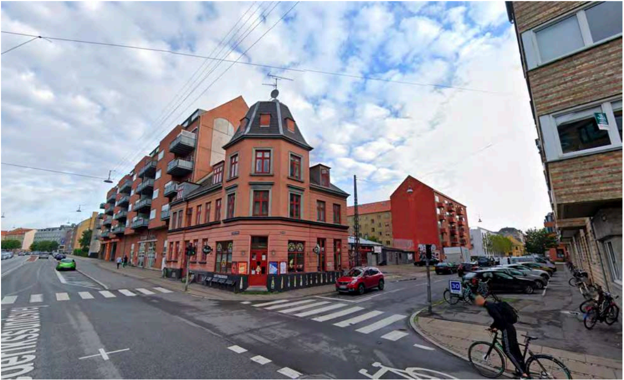
HJØRNET AF FREDERIKSSUNDSVEJ OG PROVSTEVEJ
