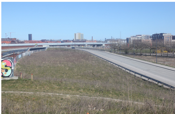
Det kommunale areal set mod øst med Ringstedbanen til venstre og Kulbanevej til højre. Det er denne strækning af Kulbanevej, der forudsættes nedlagt.
