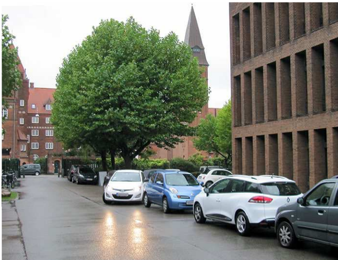
Nannasgade og Kingos Kirke set fra lokalplanområdet.
