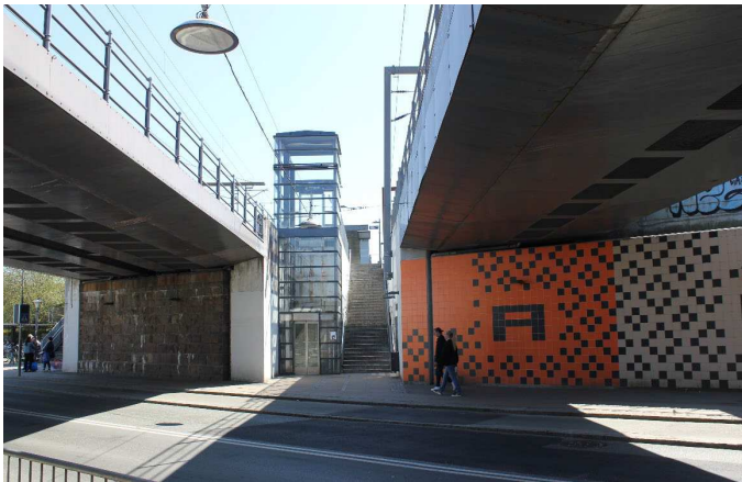
Adgang fra Vigerslev Allé til Vigerslev Allé Station med S-banen på broen til venstre og Øresundsbanen på broen til højre.
