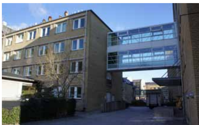
Gangbro mellem Kræftens Bekæmpelses bygninger. Der anes ligeledes en gangbro i baggrunden delvist skjult af en lastbil.
