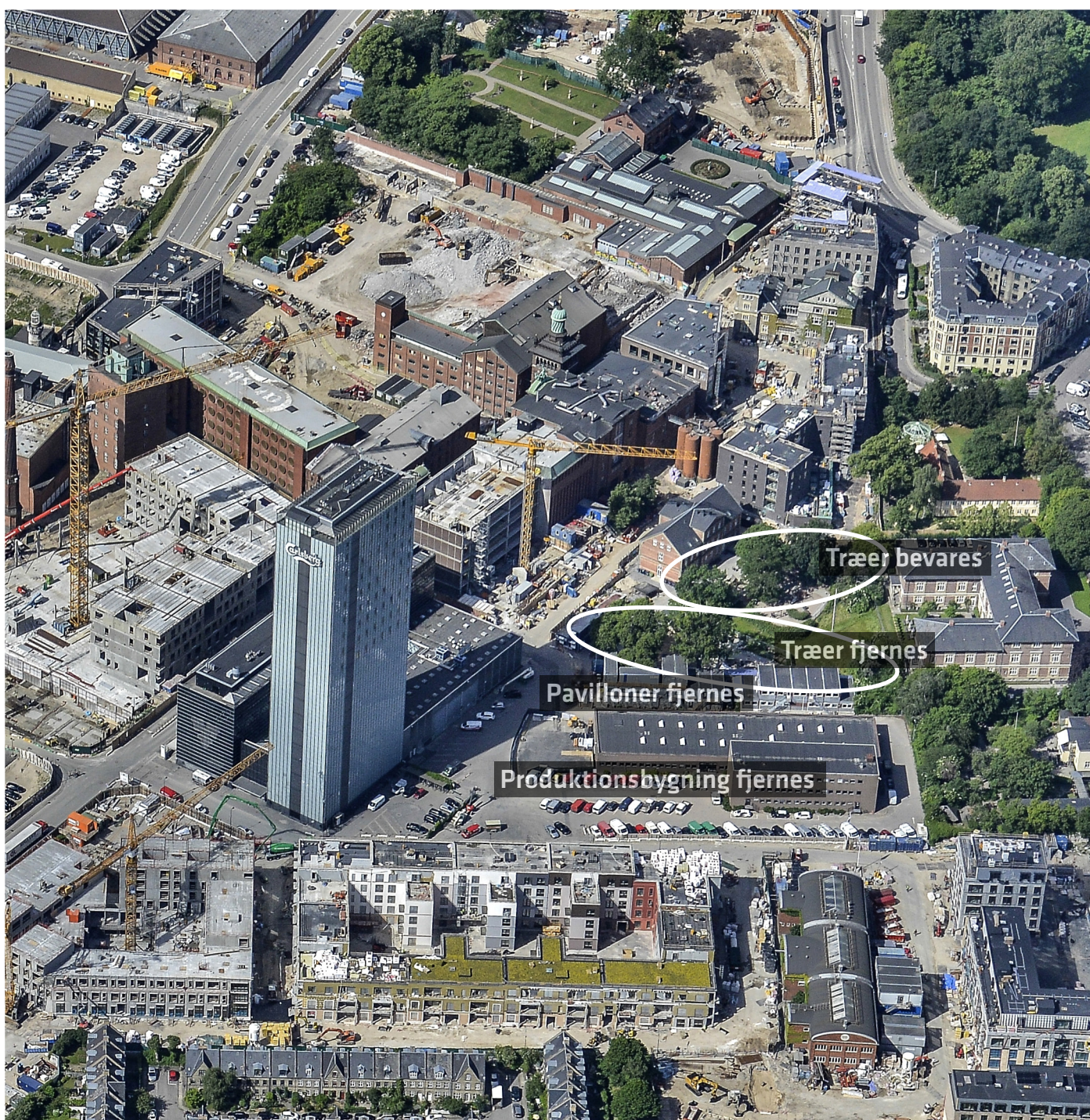
Oversigt over byggegrunden. Luftfoto fra Carlsberg Byen P/S, sommer 2017
