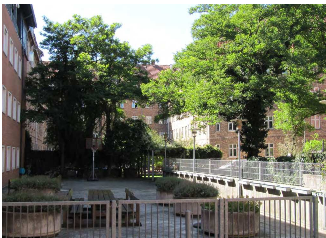
Gården til Sejrgade 9 med nedkørsel til parkeringskælder og lille gårdanlæg med store bevaringsværdige træer.
